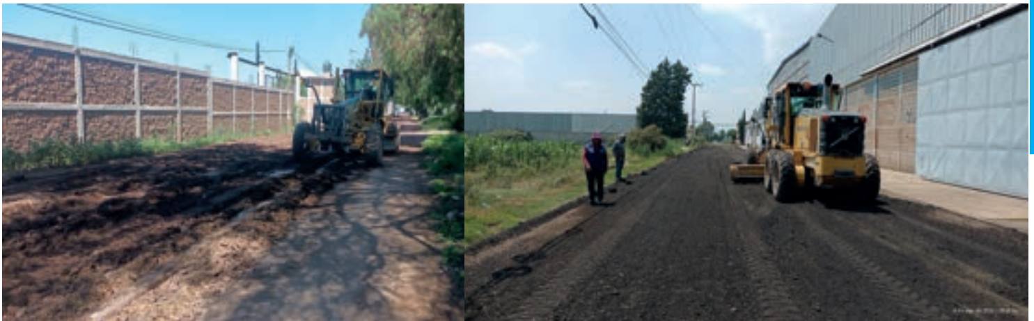
Rehabilitación y revestimiento Camino a Zurita
