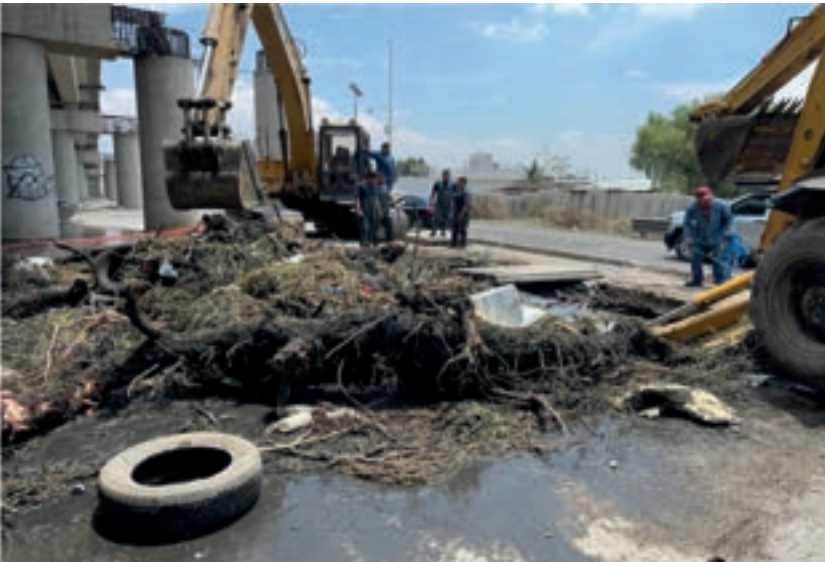
Desazolve Río San Juan por parte de la CAEM
