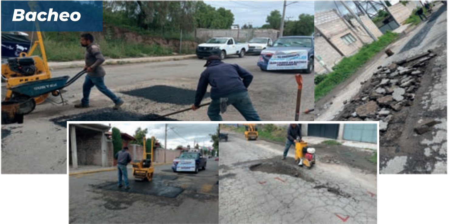
Reparación y mantenimiento de vialidades (rehabilitación de superficies de rodamiento 2023)
