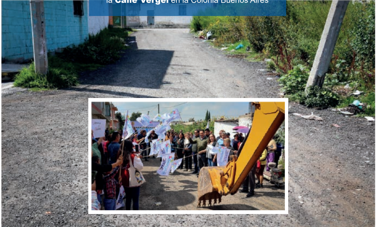
▶ Pavimentación con carpeta asfáltica de la Calle Vergel en la Colonia Buenos Aires
